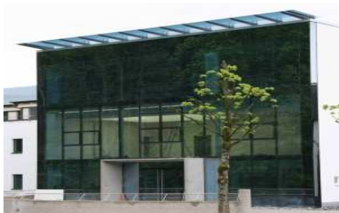
Adelholzener Mineralquellen, Bayern Fassade + Glasstreppe + Wintergarten Ausführung: 2005
