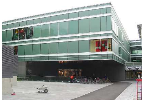
Shoppingcenter Sillpark, Innsbruck Neubau Glasfassade 1 710 m 2 satiniertes Glas Ausführung: 2007
